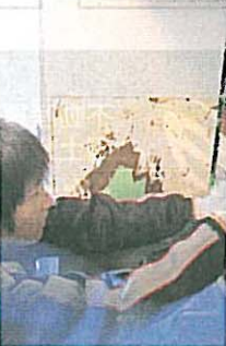
▲学生も真剣に施工
